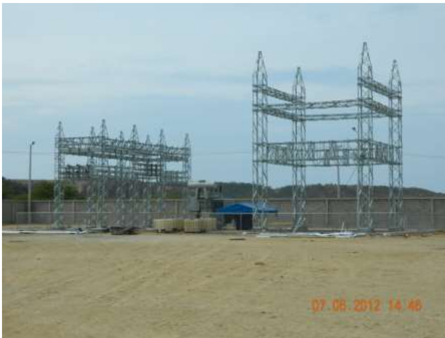
Figura 16. Subestación de San Juan de Manta (en construcción)
