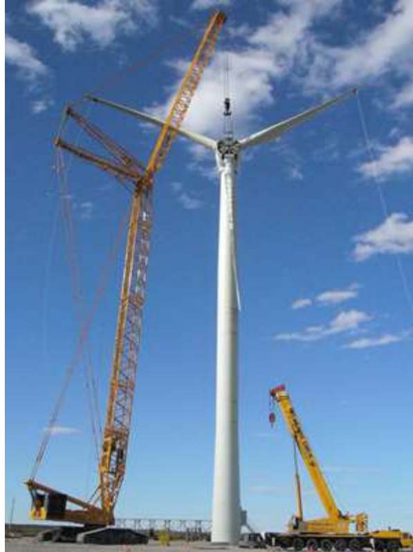
Figura 28. Montaje de turbina con grúa principal y auxiliar
