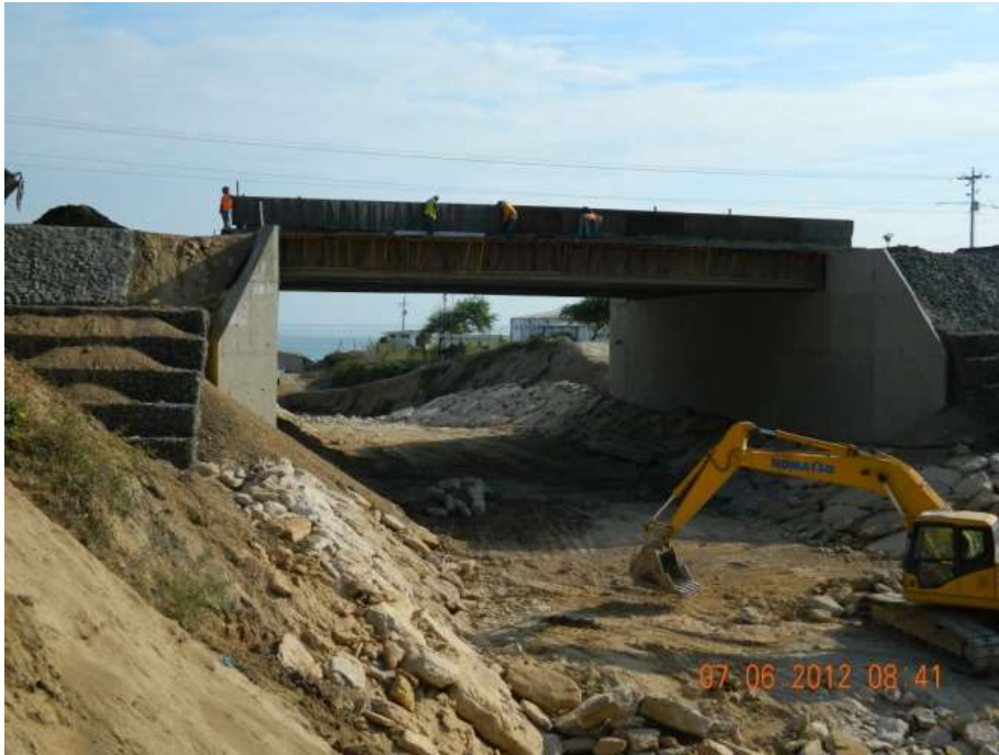
Figura 20. Puente en la vía Santa Marianita - Pacoche
