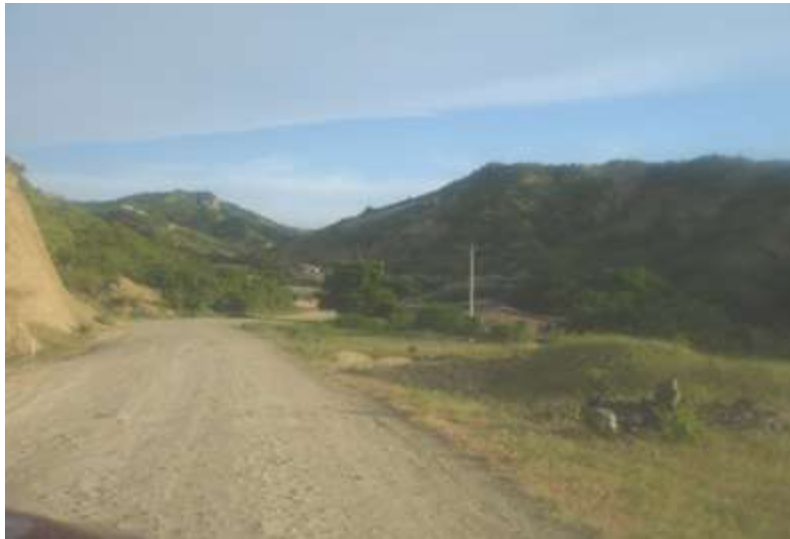
Figura 38. Vía lastrada de tercer orden que conduce al sitio del proyecto en El Aromo
